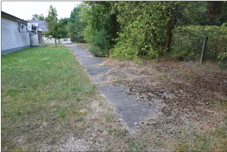
Abbildung 7: Fläche hinter dem Marktgebäude, auf dem Nachbargrundstück befindet sich eine Betonfläche als Rest einer alten Straße; Aufnahme: H. Roßmann 08/2024
