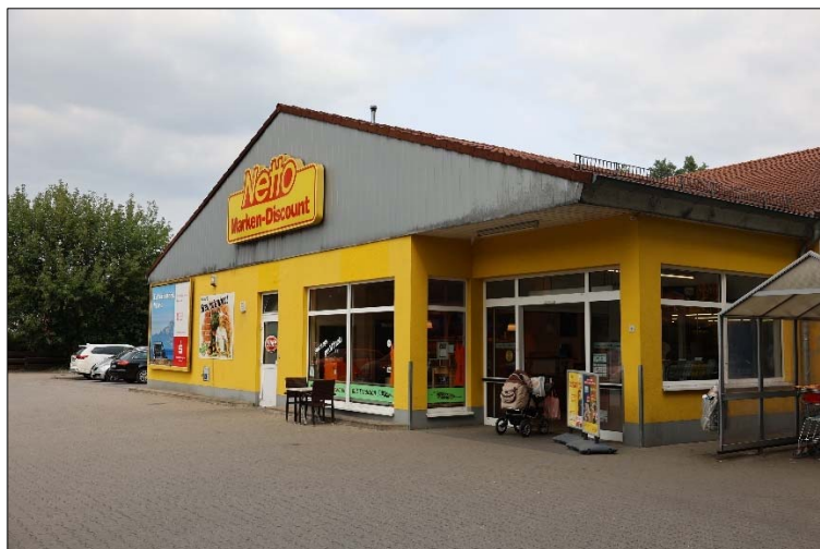
Abbildung 5: Eingangsbereich Verbrauchermarktgebäude; Aufnahme: H. Roßmann 08/2024
