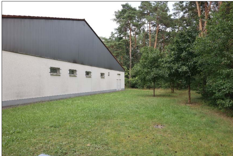
Abbildung 4: Fläche für die geplante Erweiterung des Gebäudes; Aufnahme: H. Roßmann 08/2024
