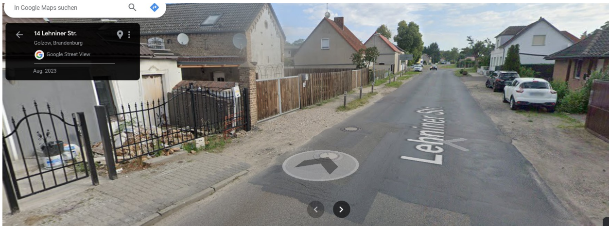
Bauanfang Gehweg Lehniner Straße bei Nr. 14
