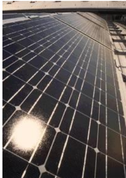
Abbildung 8: Streuung der gerichteten Strahlung/Sonnenstrahlung
