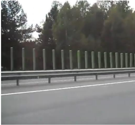
Abbildung 28: Blendschutzmaßnahme in Form von Hohlkörperlamellen, die direkt an der Schutzplanke der BAB 9 installiert wird
